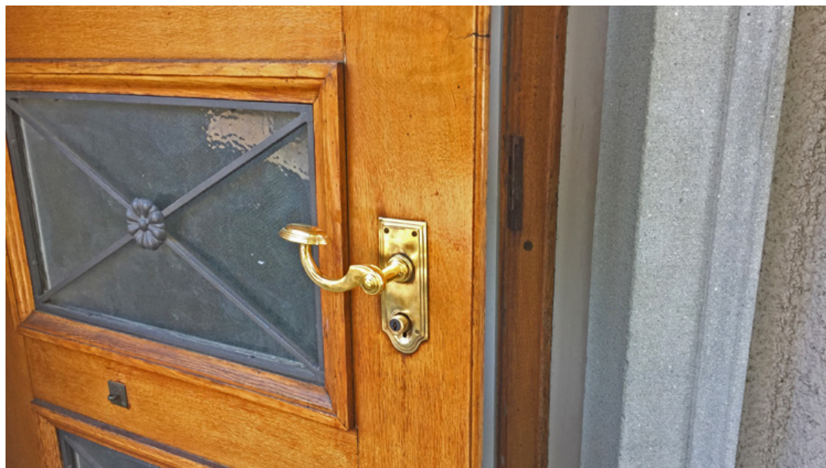
Nach Jahrzehnten wieder ein Eingang: Neue Messingfalle an der Tür des südöstlichen Hintereingangs der Grossen Kirche
